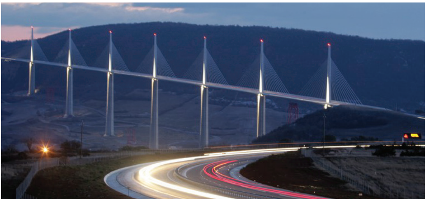
Viaduc de Millau
