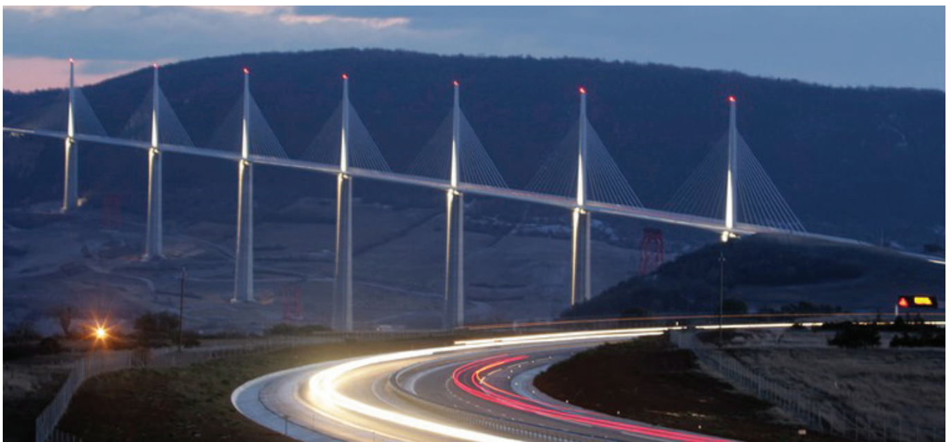
Viaduc de Millau
